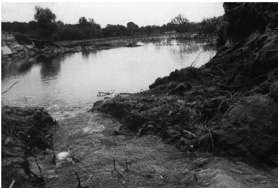
Przerwany wał w Stobrawie
